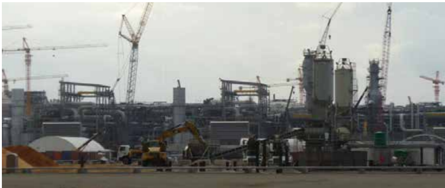
Estación de gas natural licuado presurizado Soyo - Angola
