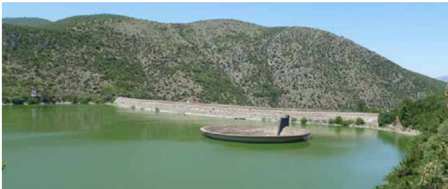
Presa de Tikves - Macedonia
