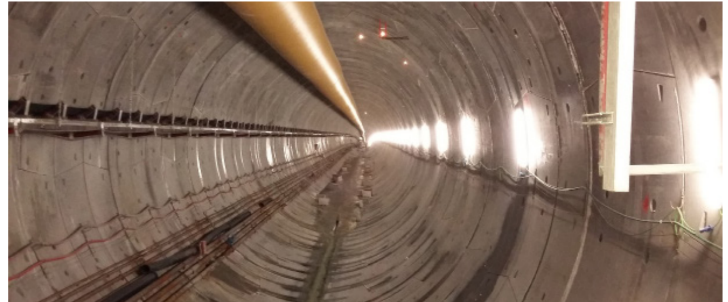
Porto Empedocle 2 Túnel - Italia
