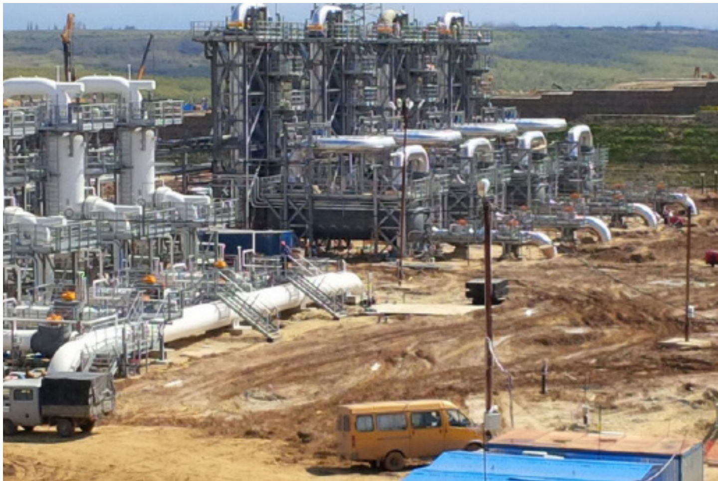
Planta de Tratamiento de Gas - Rusia
